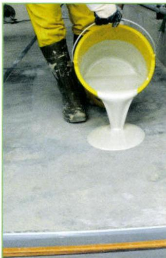
**7. Verteilen des Gemisches:** Das fertige Epoxydharzgemisch wird gleichmäßig auf der Fläche verteilt.
