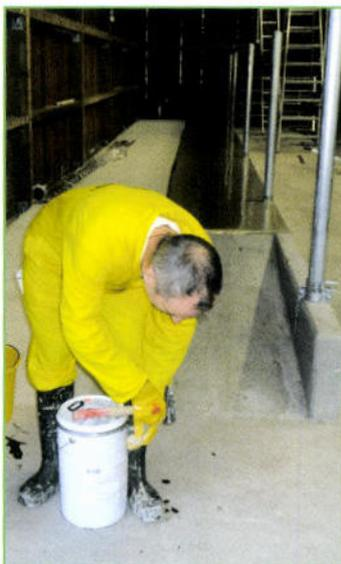
**4. Aufwandmenge bestimmen:** Die Aufwandmenge variiert in Abhängigkeit vom Zustand des Altbetons. In der Regel reicht ein Gebinde für etwa acht bis zehn Fressplätze aus. Geöffnet werden die Gebinde, indem mit Hammer und Schraubenzieher der Deckel durchgeschlagen wird.
