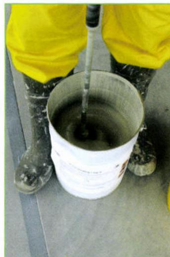
**6. Mischen der Komponenten:** Nachdem die beiden Komponenten eine Verbindung eingegangen sind, müssen diese gründlich mit der Bohrmaschine und einem entsprechenden Aufsatz verrührt werden.
