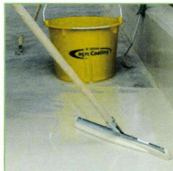
**8. Gleichmäßiges Verteilen:** Nach dem Ausgießen der Epoxydharzmischung auf der Fläche wird die Mischung mit einem Wasserabzieher gleichmäßig verteilt. Hierbei ist es sinnvoll, am Ende der zu versiegelnden Fläche eine Rille in den Beton zu schneiden, in welche das Harz hineinlaufen kann und die eine glatte Kante bietet. Diese bildet einen sauberen und stabilen Abschluss.
