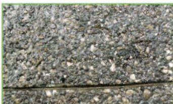
**3. Sanierungsbedarf wird deutlich:** Nach der gründlichen Reinigung zeigt sich erst das ganze Ausmaß des Sanierungsbedarfs. Grundsätzlich gilt: je rauer der Altbeton, desto höher ist auch der Aufwand an Epoxydharz, wodurch die Aufwandmenge sehr stark variieren kann.
