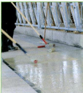
**9. Nachbearbeitung:** Mit einem Roller wird die Epoxydharzmischung noch einmal nachbearbeitet, um eine gleichmäßige Verteilung zu gewährleisten.
